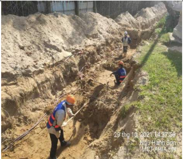
Sửa chữa hố móng tường chắn PulChra đoạn 3A trục 9-10
