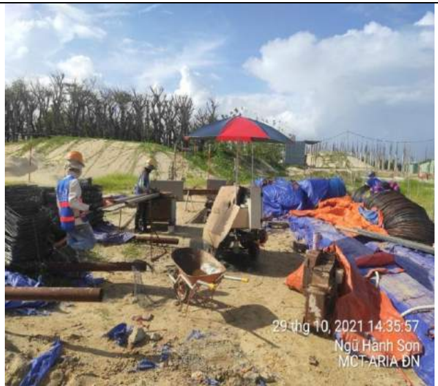
Gia công thép bể cân bằng BT1.2
