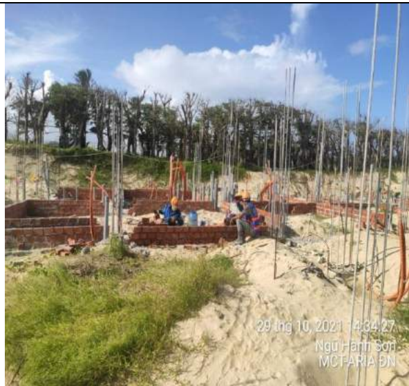
Xây gạch biện pháp dầm tầng 1 căn C, F BT1.2
