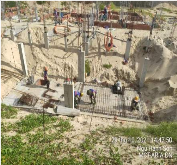
Lắp dựng thép bể cân bằng biệt thự BT1.2 căn C, D
